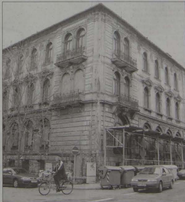
Einst Verlagshaus, heute Ruine: Die Wirkungsstätte von Edvard Grieg in der Talstraße 10 verfällt zusehends.
