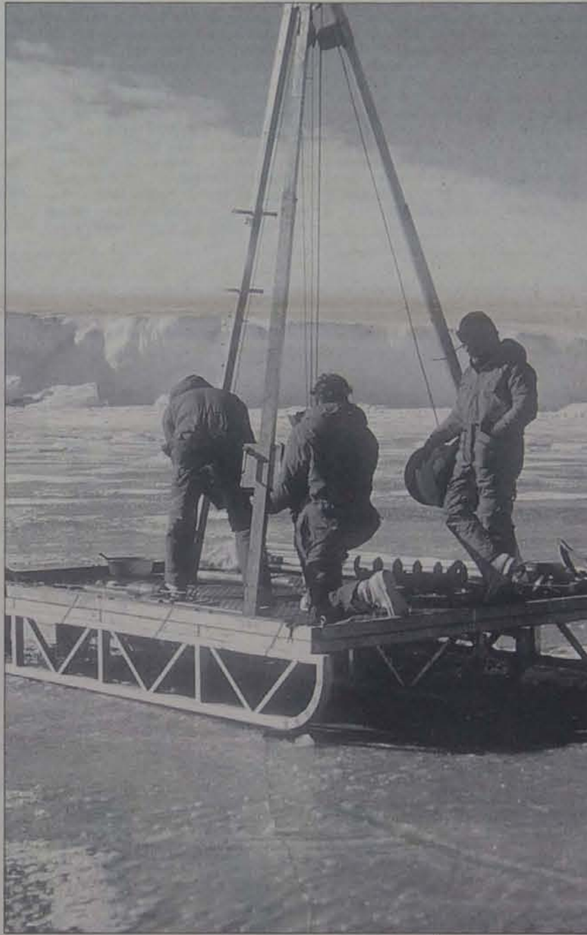
In der Windmill-Oase bergen Antarktis-Forscher Proben durch die geschlossene Eisdecke: Über Handwinden werden die Sedimente nach oben gezogen. Foto: Martin Melles
