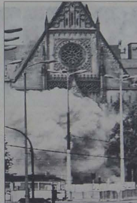
Sprengrung der Paulinerkirche 1968. Foto: Archiv
